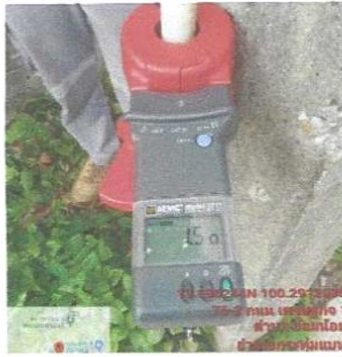
ภาพถ่ายค่าความต้านทานดิน
